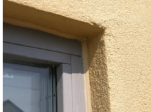
Figur 8.11 Först efter omfattande tätning med mjukfog stoppades läckage in i väggen i fasad med tunnputs på cellplast. Väggen var då redan allvarligt rötskadad.
