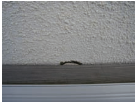
Figur 8.13 Otät infästning av solskydd sedd från ovan (mätvärde i gips under infästning 0,39). Fasaden har tunnputs på EPS.
