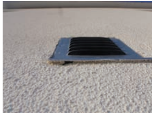
Figur 8.7 Otät anslutning mellan friskluftsventil och puts i fasad med tjockputs på mineralull. Indikationsmätning: 0,20.
