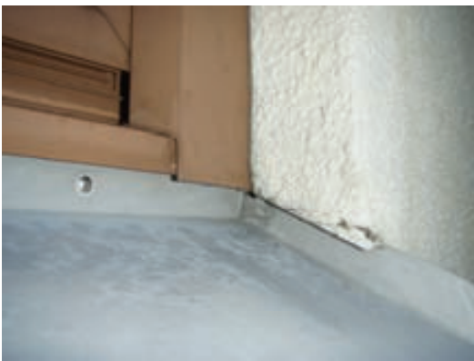
Figur 8.14 Otäthet vid fönsterbleck i fasad med tunnputs på cellplast. Mätvärde i gipsskivan under fönstret 0,51.
