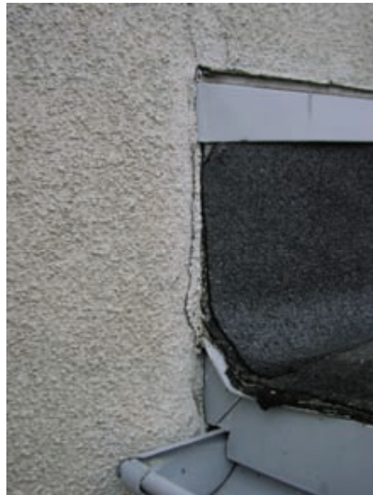
Figur 8.3 Exempel på otäthet vid ett plåtbleck i en fasad med tunnputs på EPS. Indikationsmätning i gipsskivan 0,99.
