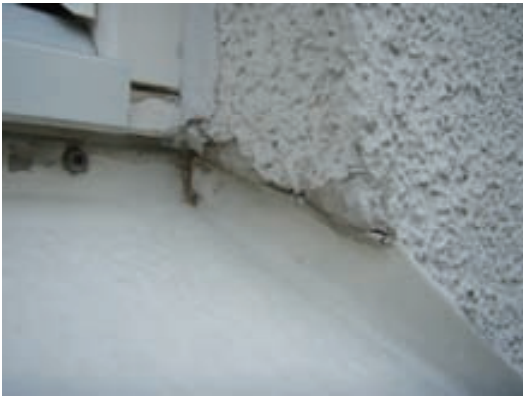
Figur 8.16 Otäthet vid fönsterbleck i fasad med tunnputs på cellplast. Mätvärde i gipsskivan under fönstret 0,65.
