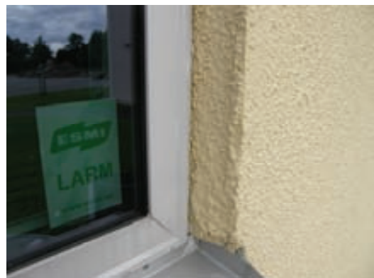
Figur 8.9 Spricka vid fönster som orsakat omfattande läckage in i en fasad med tunnputs på mineralull. Rötskador.
