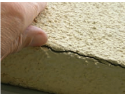
Figur 8.8 Spricka i hörn över fönster i fasad med tunnputs på mineralull. Vatten rann ut ur sprickan.
