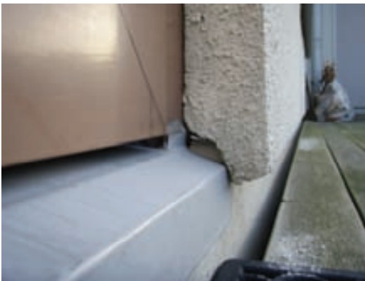
Figur 8.12 Otäthet vid dörr i fasad med tunnputs på cellplast, fuktindikation i gipsskivan 0,59.
