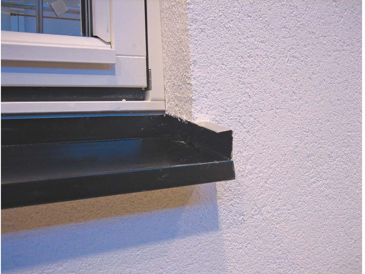
Bilden visar hur en byggnad med putsade, enstegstätade regelväggar kan se ut. Bilden är tagen i samband med en provning på laboratorium.
