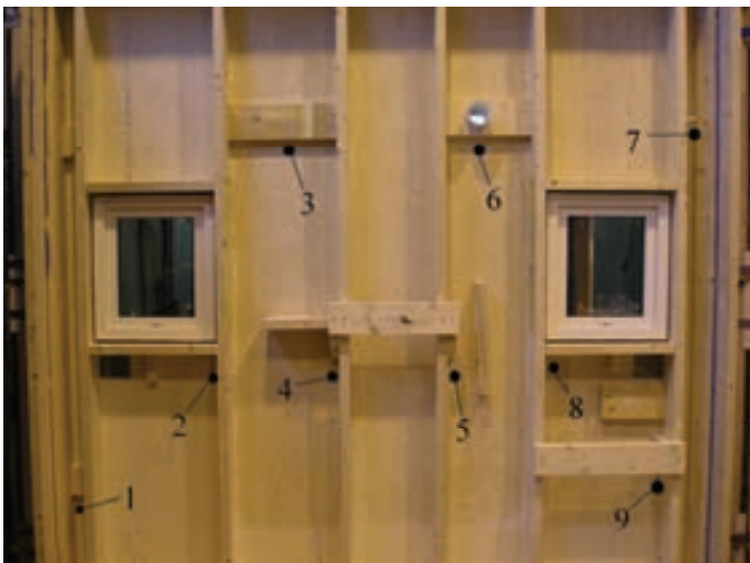
Figur 10.2 Provväggens baksida med markeringar för mätpunkter i anslutning till genomföringarna.
