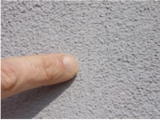
Figur 8.10 Spricka i tunnputs på cellplast som orsakade läckage in till gipsskivan. Vatten rann in genom sprickan och genom isoleringen och blötte upp gipsskivan 10 minuter efter att fasaden utsatts för vatten.
