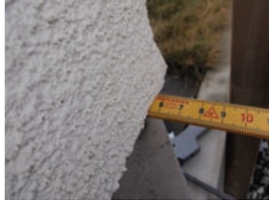
Figur 8.5 Otäthet i anslutningen mellan puts och sockel i en vägg med tjockputs på mineralull. Indikationsmätning: 0,20.
