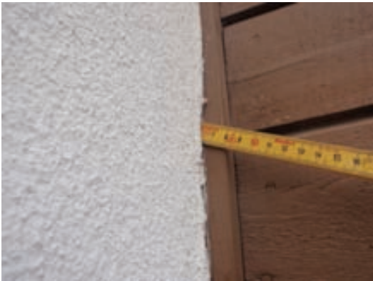
Figur 8.6 Otät anslutning mellan puts och trä i en fasad med tjockputs på mineralull. Indikationsmätning 0,27.
