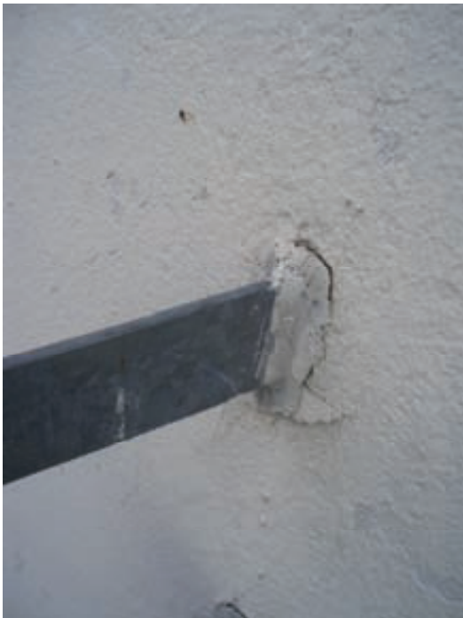
Figur 8.2 Exempel på otäthet vid en infästning i en fasad med tjockputs på mineralull. Indikationsmätning i gipsskivan under infästningen 0,20.
