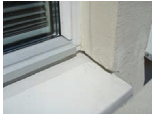
Figur 8.17 Ett till synes felritt utförande i en vägg med tunnputs på cellplast. Trots detta mättes en fuktindikation på 0,99 under fönsterblecket.
