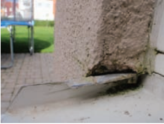
Figur 8.4 Otätheter i anslutningen mellan fönsterbleck och puts i fasad med tunnputs på cellplast. Indikationsmätning strax under: 0,87.
