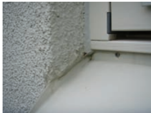
Figur 8.15 Knappt synlig otäthet vid fönster i fasad med tunnputs på cellplast. Mätvärde i gipsskivan under fönstret 0,45.
